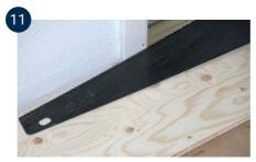
Türverkleidungen können entfernt und nach oben versetzt werden, aber es ist meist einfacher, sie abzusägen. Verwenden Sie eine lose Diele als Höhenschablone und sägen Sie die Verkleidung mit einer fein gezahnten Säge ab. Schieben Sie den Boden unter die Verkleidung. Siehe auch Punkt 10.
