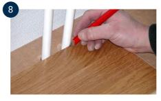
Bei einem Rohr an der langen Seite der Diele: Löcher mit einem Durchmesser von ca. 10 mm größer als das Rohr selbst bohren. Messen Sie, wie weit vom Ende der Diele die Löcher gebohrt werden sollen.
