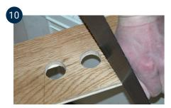
Sägen Sie das Stück ab, das hinter den Rohren und am nächsten zur Wand platziert werden soll. Schneiden Sie schräg, wie in der Abbildung gezeigt. Wenn sich die Löcher am kurzen Ende der Diele befinden, wird die Diele in einem 90°-Winkel gerade durch die Löcher geschnitten. MS-Kleber auf den Untergrund und anschließend Holzklebstoff an den zu verlegenden Seiten der Diele auftragen. Klopfen Sie die Diele an ihren Platz und decken Sie sie mit Rohrmanschetten ab.
