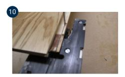
Ist kein Platz zum Herunterklappen der letzten Diele vorhanden, kann sie stattdessen seitlich eingeschoben werden. Dazu muss zunächst die Feder der vorletzten Dielenreihe begradigt werden. Verwenden Sie dazu z. B. eine Stichsäge oder einen Stechbeitel und entfernen Sie den überstehenden Teil am Ende der Feder.
