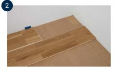
Am Ende der Reihe die letzte Diele so drehen, dass die Feder an der Feder anliegt. Drücken Sie das kurze Ende fest gegen die Wand.
