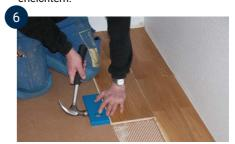
Verlegen Sie den Boden Diele für Diele und legen Sie einen Keil gegen die Wand. Wiederholen Sie die Schritte 1–5, beginnend mit der abgeschnittenen Diele. Beachten Sie, dass der Abstand zwischen den Endfugen über den gesamten Boden mindestens 500 mm betragen sollte. Dies gilt nicht für Start- und Stopp-Dielen.
