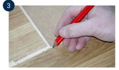
Markieren Sie mit einem Bleistift den Schnitt 4–5 mm vom kurzen Ende der vorherigen Diele, um das Absenken der Diele zu erleichtern.
