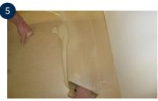
Nehmen Sie die ausgelegte Dielenreihe auf. Klebstoff entsprechend der gesamten Dielenreihe auf den Unterboden auftragen. Verlegen Sie den Boden Diele für Diele und legen Sie einen Keil gegen die Wand.
