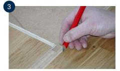
Am Ende der Reihe die letzte Diele so drehen, dass die Nut an der Nut anliegt. Drücken Sie das kurze Ende fest gegen die Wand. Markieren Sie mit einem Bleistift den Schnitt 4–5 mm vom kurzen Ende der vorherigen Diele, um das Absenken der Diele zu erleichtern.
