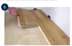
Wiederholen Sie die Schritte 2–4, nehmen Sie den Kleber auf und verteilen Sie ihn. Beginnen Sie die zweite Reihe mit dem abgeschnittenen Diele aus der ersten Reihe. Die Bodenplatte in die Nut einlegen und in das Klebebett drücken.
