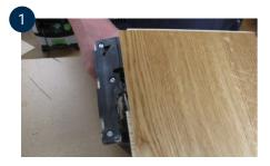
Vor dem Verlegen der ersten Reihe muss zunächst das vorstehende Holzprofil an der Federseite der Diele abgeschnitten werden.
